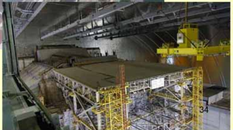
新シェルター内部
