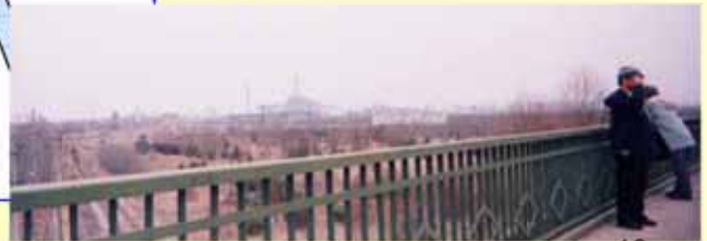
ヤノフ駅東の跨線橋 2000年
