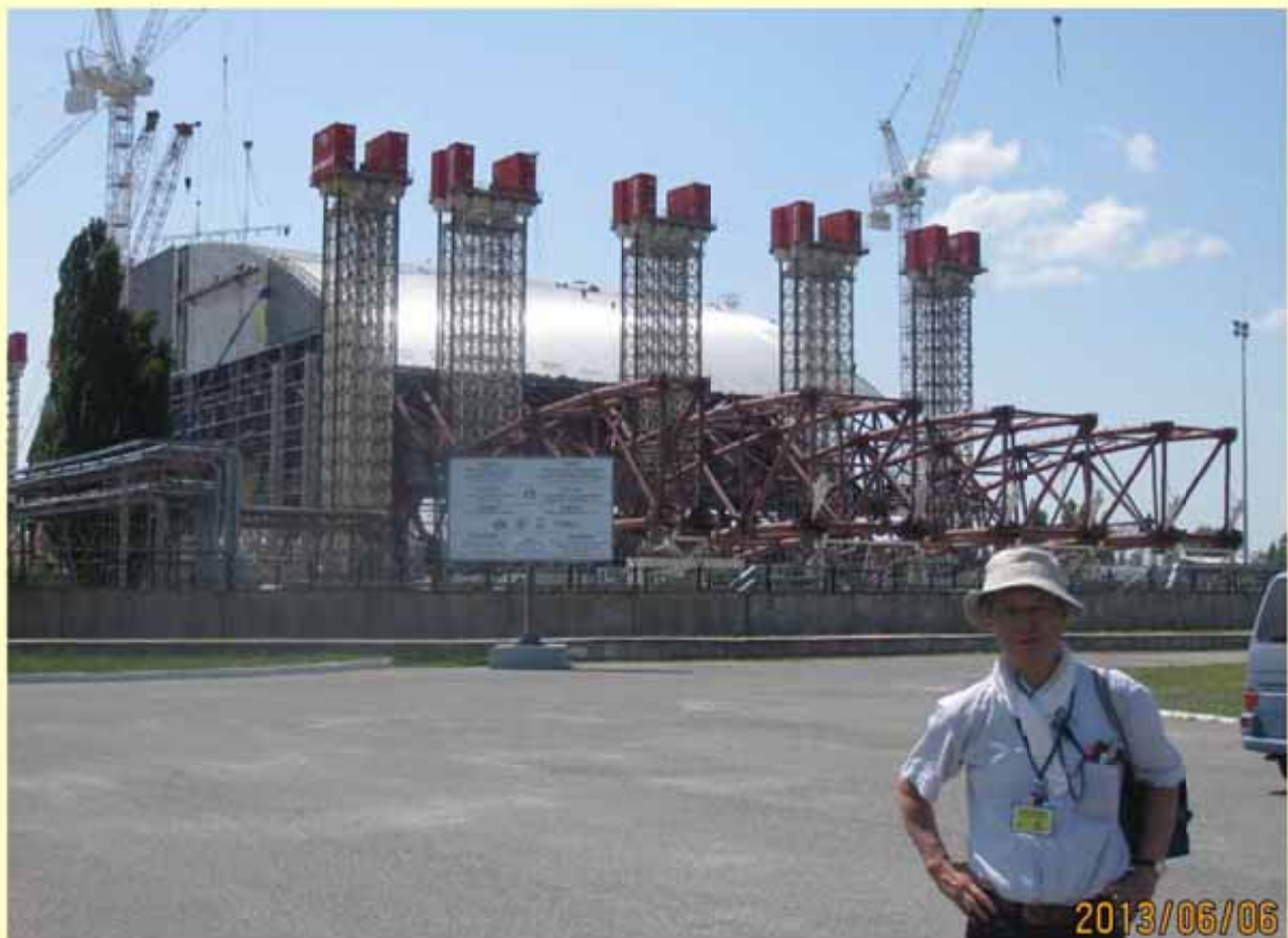
2013年6月 新シェルター建設現場 材料はステンレスで、耐用年数100年の設計だそうだ 33
