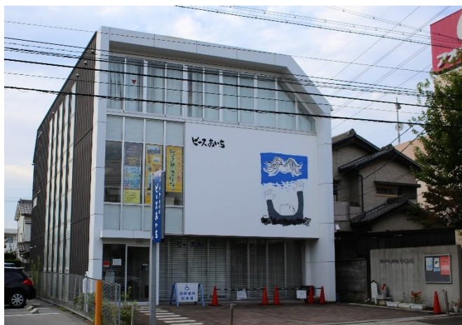
＜名古屋市名東区に建つ「ピースあいち」の外観＞
